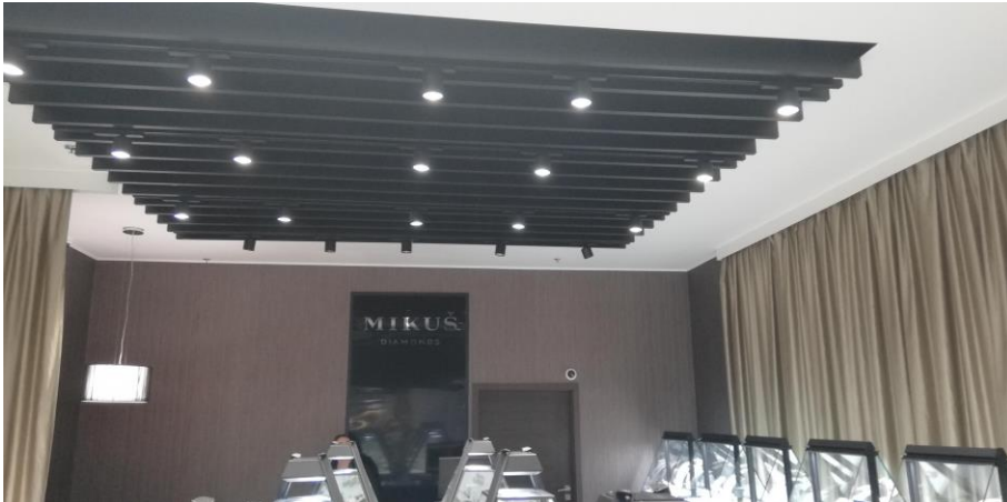
Obr. č. 3 – Podhľad – zavesené lamely
